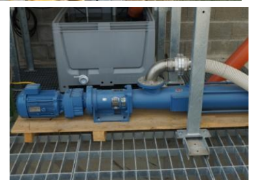
EXZENTERSCHNECKENPUMPE
